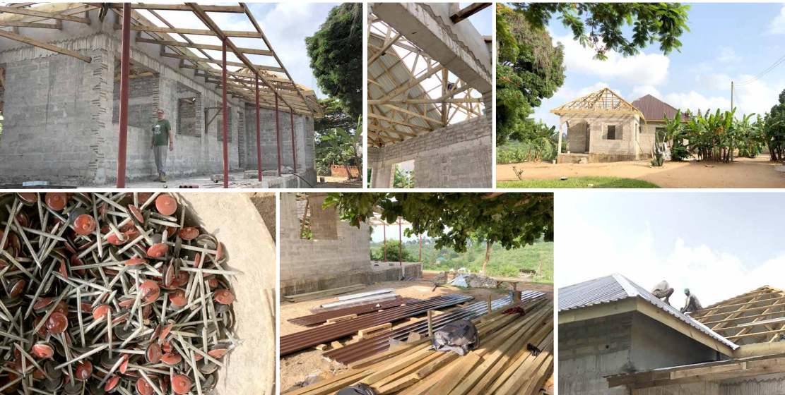
Die neue Bildungsstätte ist endlich fertig! Unten einzelne Bilder aus der Bauphase
